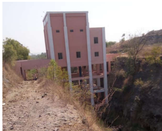
निरीक्षण पथ एलआईएस पंप हाउस
